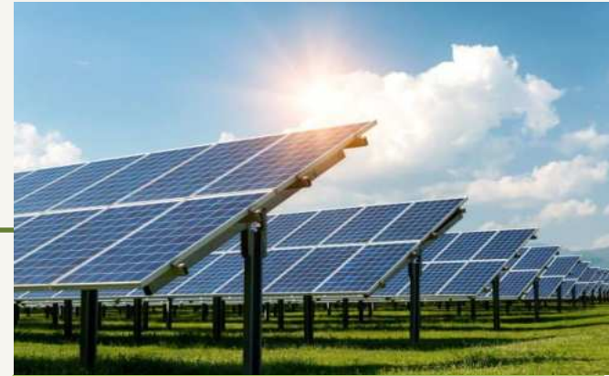
Güneş Enerjisi Santrali Kurulması
